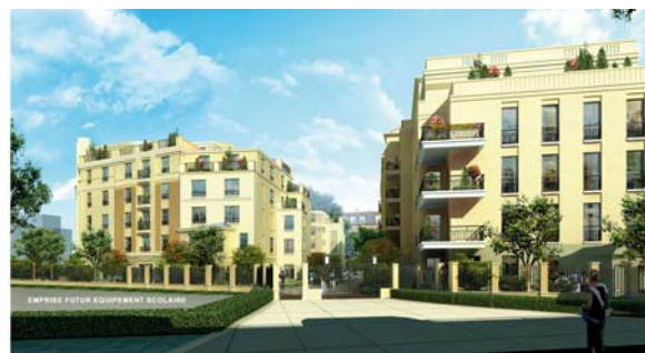
Chantier CHARENTON - GABRIEL PERI
